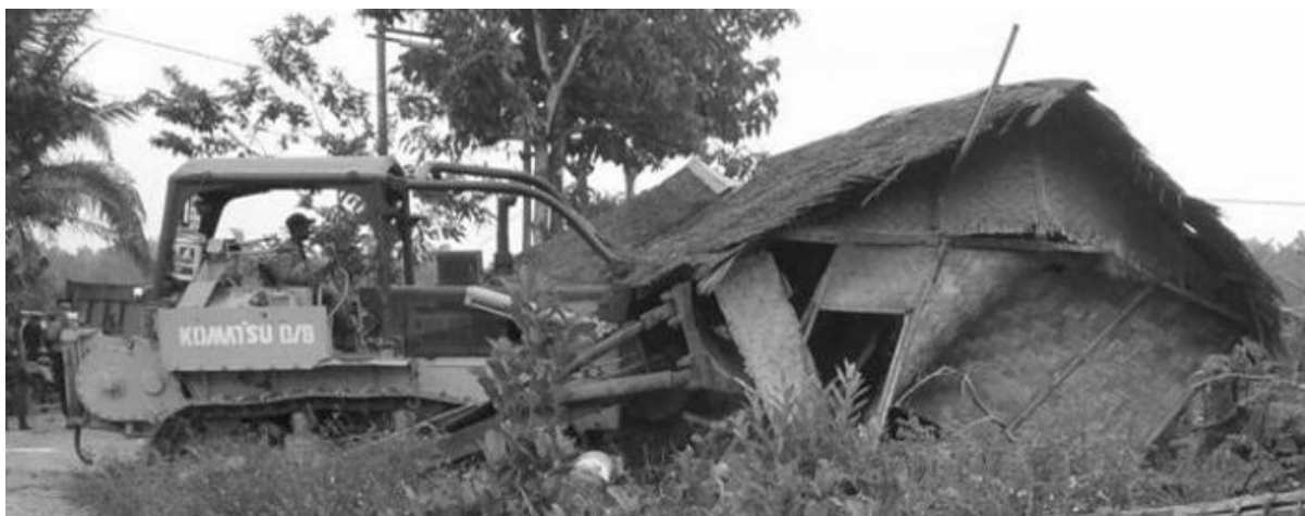
Szenen aus dem Dorf Mekar Jaya, in dem mit der Hilfe von Polizeikräften mehrere Bauernhäuser zugunsten einer Plantagenfirma abgerissen wurden
